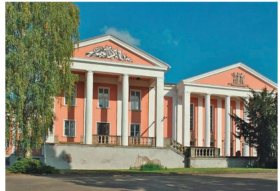
Haupteingang und linker Nebenflügel des Kulturpalastes Unterwellenborn
